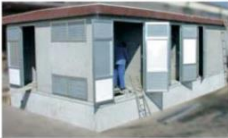
Slika 8. Prikaz tipične armiranobetonske transformatorske stanice
