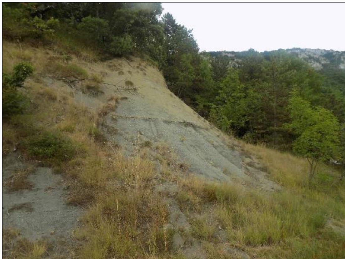
Slika 22. Prikaz temeljne stijene na lokaciji UPOV-a Jakomasi građene od nepropusnih slojeva lapora dok se u pozadini vidi navučeni kompleks vapnenih stijena Čičarije
