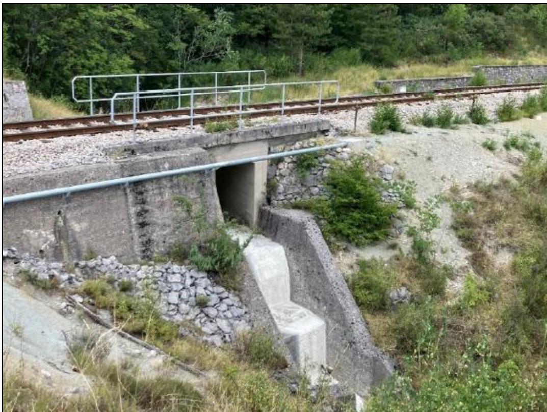
Slika 24. Propust kroz prugu Roč – Lupoglav bujičnog ogranka bujice Kompanj
