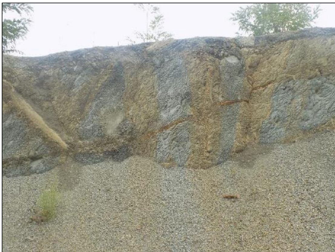
Slika 23. Trošni lapor sa sustavom dijagonalnih pukotina (klivaž) debljine trošenja do 5 m
