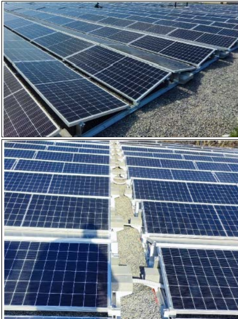
Slika 15. Prikaz primjera montaže fotonaponskih modula na aluminijskoj konstrukciji (pri tlu) (Izvor: Tehnokom d.o.o., siječanj 2025.)
