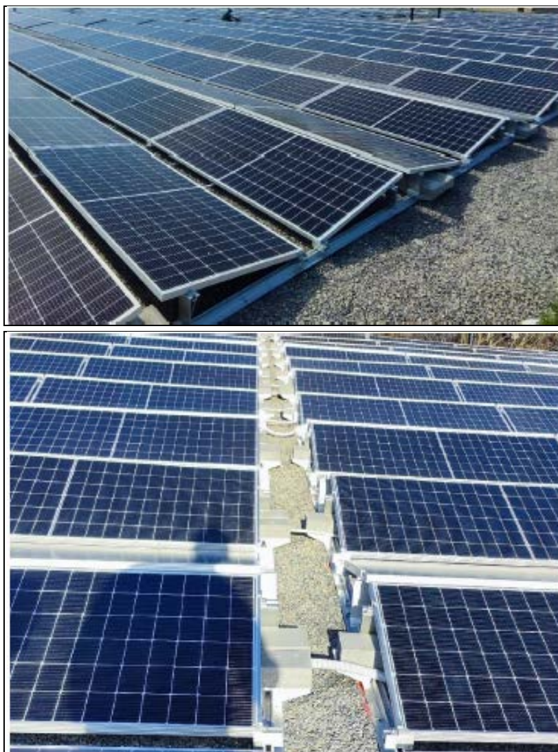
Slika 7. Prikaz primjera montaže fotonaponskih modula pri tlu (Izvor: Tehnokom d.o.o., ožujak 2025.)
