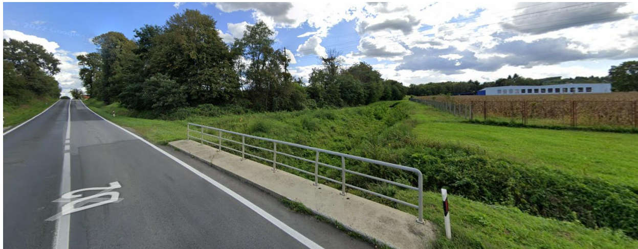
Slika 3.3-16 Pogled na lokaciju UPOV-a, vodotok Koševac i tvornicu vreća i tiskaru s državne ceste DC2 (Izvor: Google Street View)
