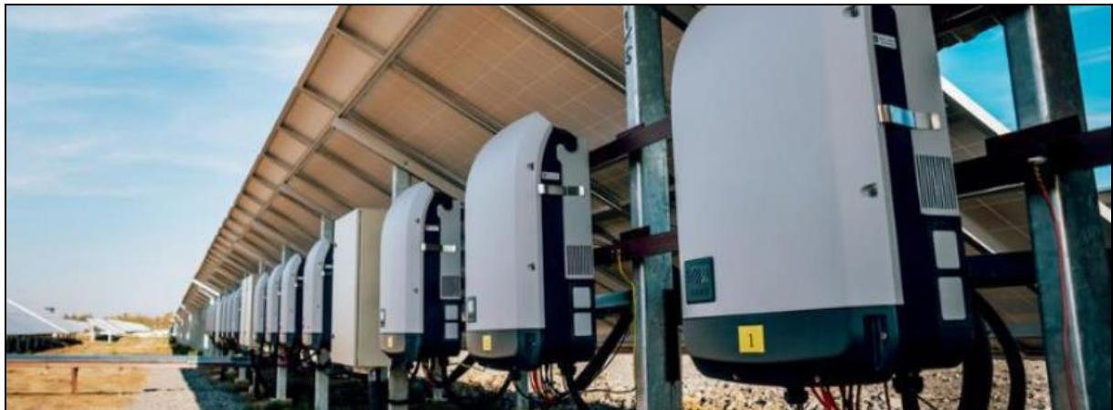
Slika 3. Primjer montaže invertera uz profilne nosače konstrukcije (Izvor: Idejno rješenje)
