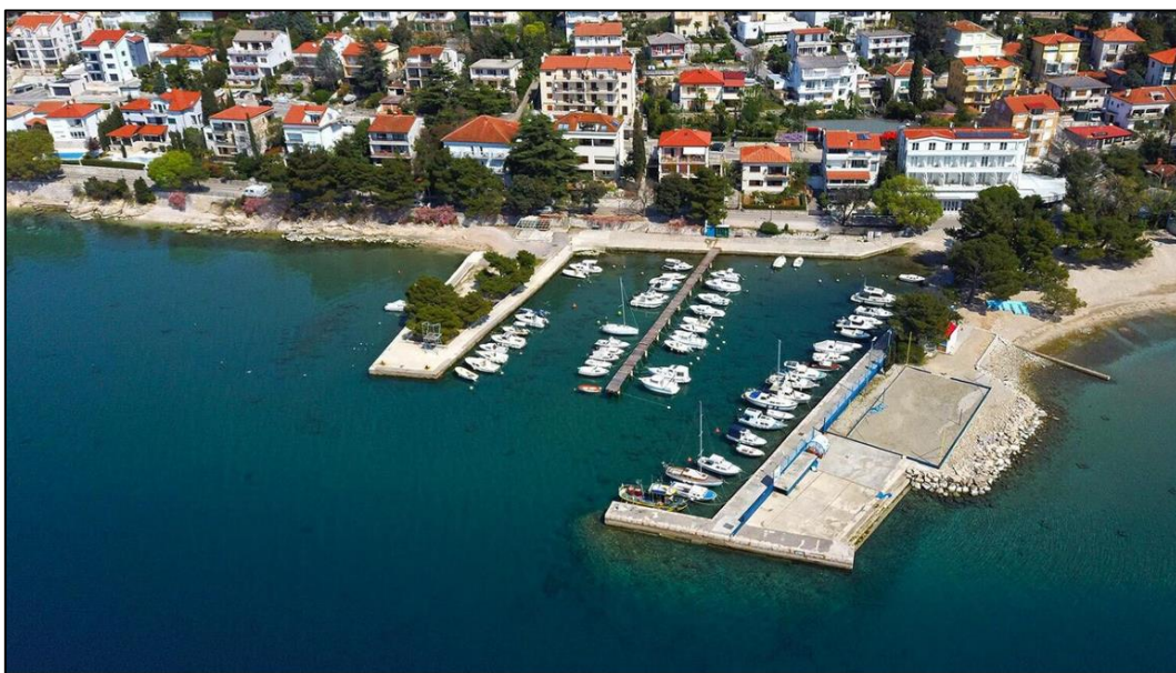
Slika 1. Postojeće stanje luke Črni mul (Izvor: www.zlu-cr-ikvenica.hr )
