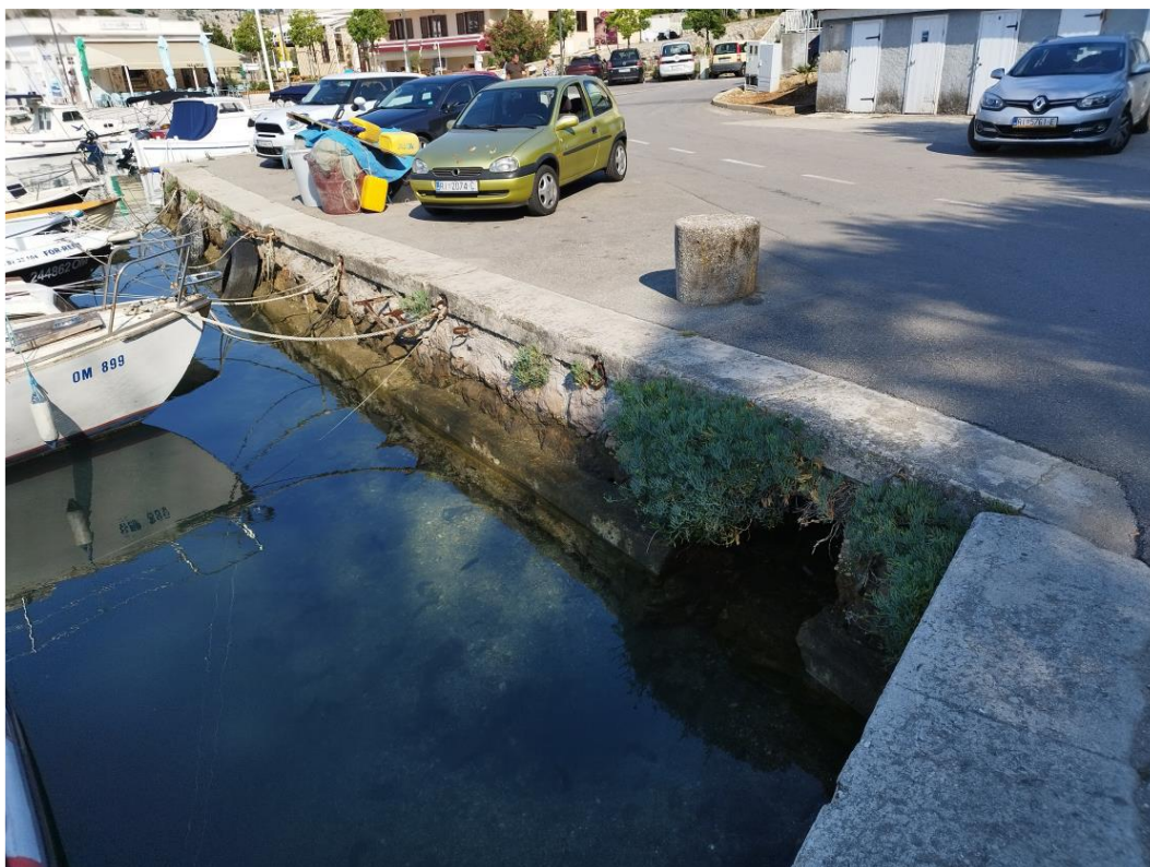
Slika 4. Pogled na obalni zid u sjevernom dijelu luke prije stacionaže 0,00 m
