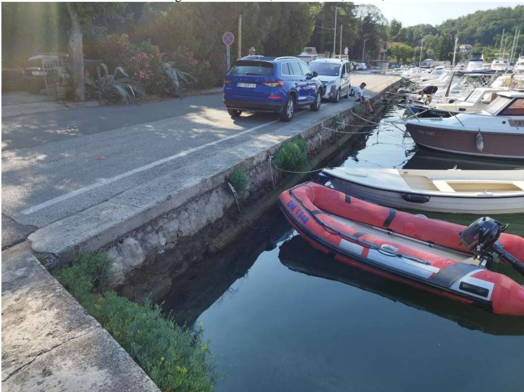
Slika 5. Pogled na obalni zid, stacionaža 0,00 i 87,73 m
