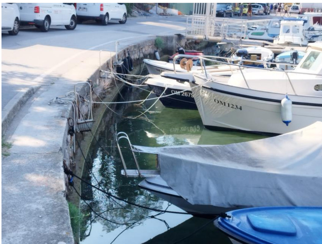
Slika 6. Pogled na obalni zid, stacionaža 87,73 m – 117,76 m
