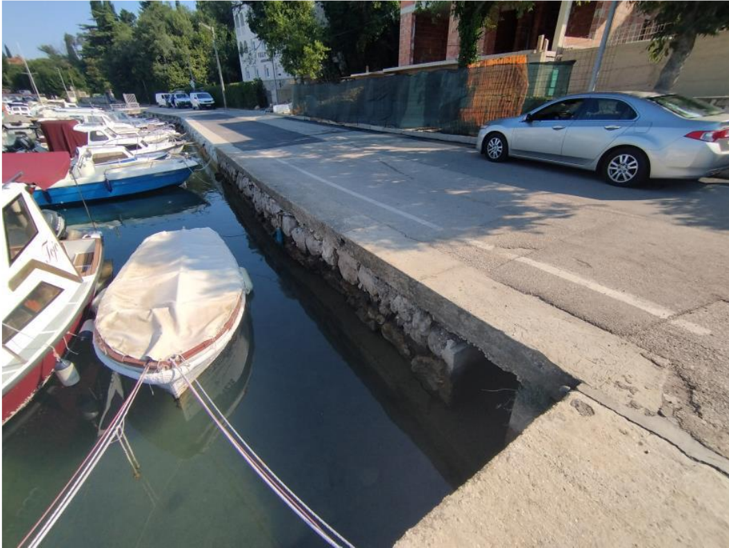
Slika 7. Pogled na obalni zid, stacionaža 117,76 m – 157,74 m
