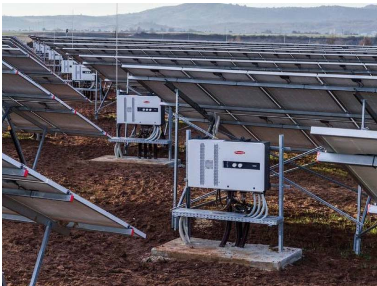
Slika 10. Primjer ugradnje izmjenjivača
