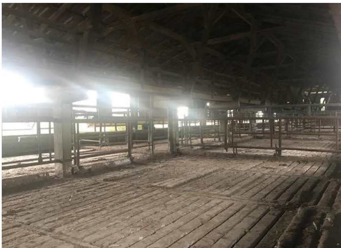
Slika 14. Staja za tov goveda – unutarnji prostor (sve tri građevine identične)
