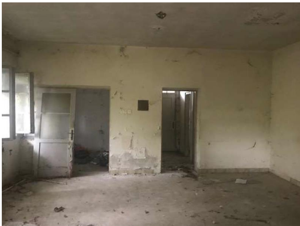
Slika 20. Upravna građevina – unutarnji prostor
