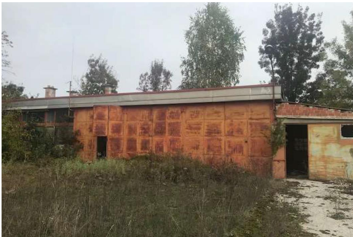
Slika 17. Spremište poljoprivredne mehanizacije – vanjski prostor
