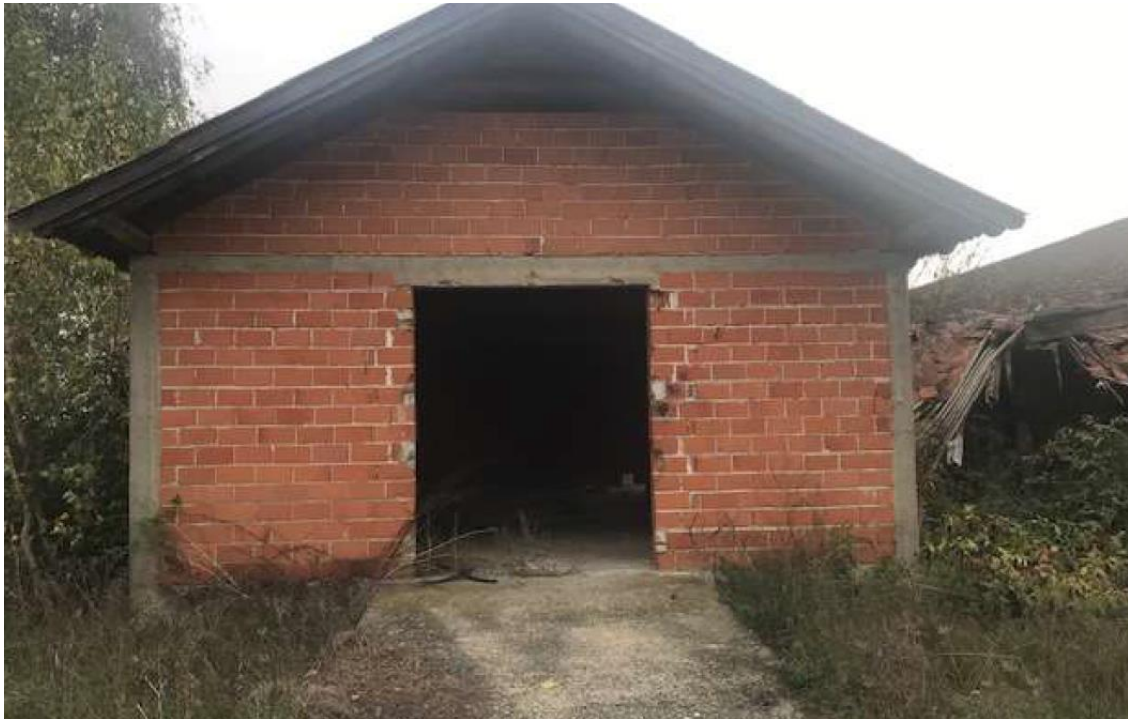
Slika 15. Spremište poljoprivredne mehanizacije – vanjski prostor
