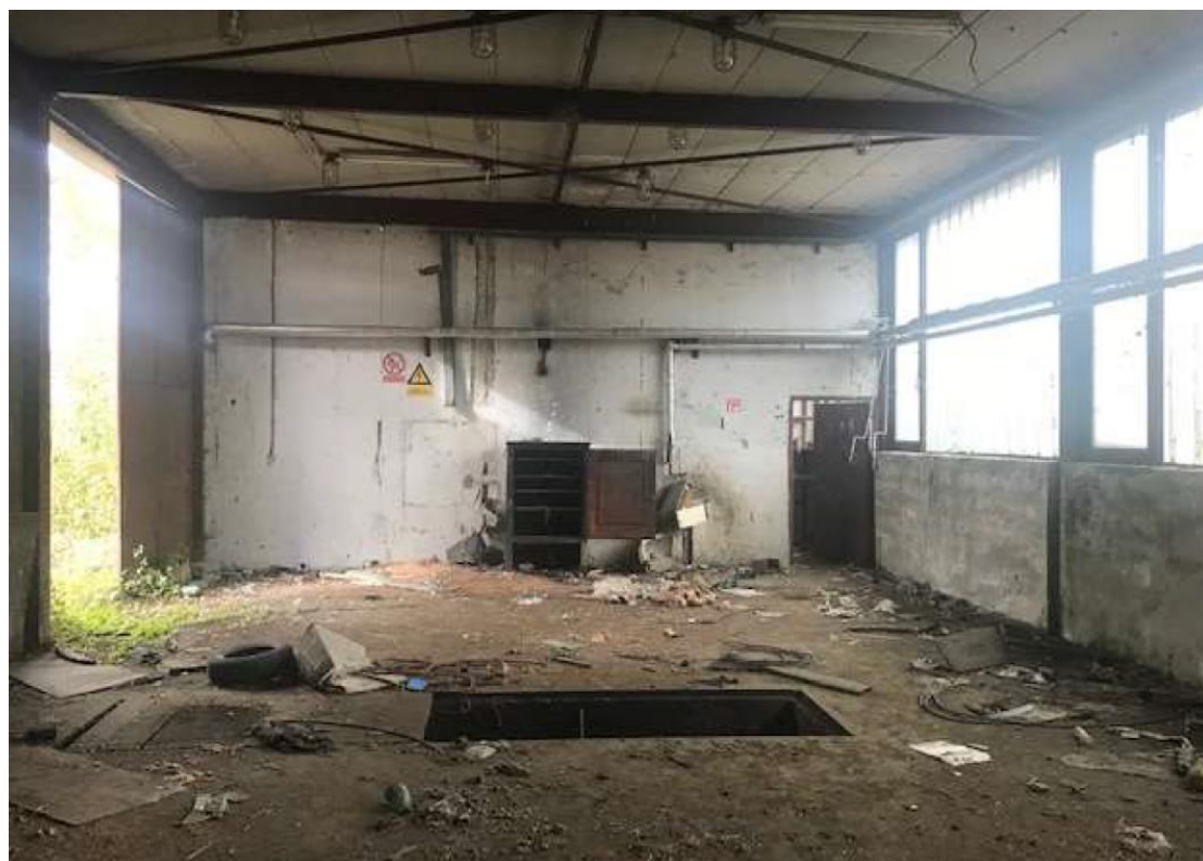
Slika 18. Spremište poljoprivredne mehanizacije – unutarnji prostor
