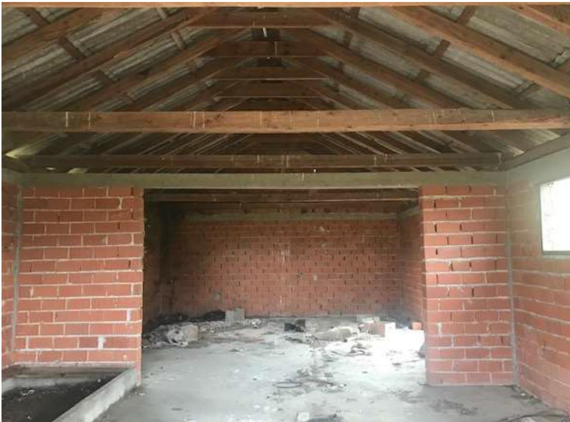
Slika 16. Spremište poljoprivredne mehanizacije – unutarnji prostor
