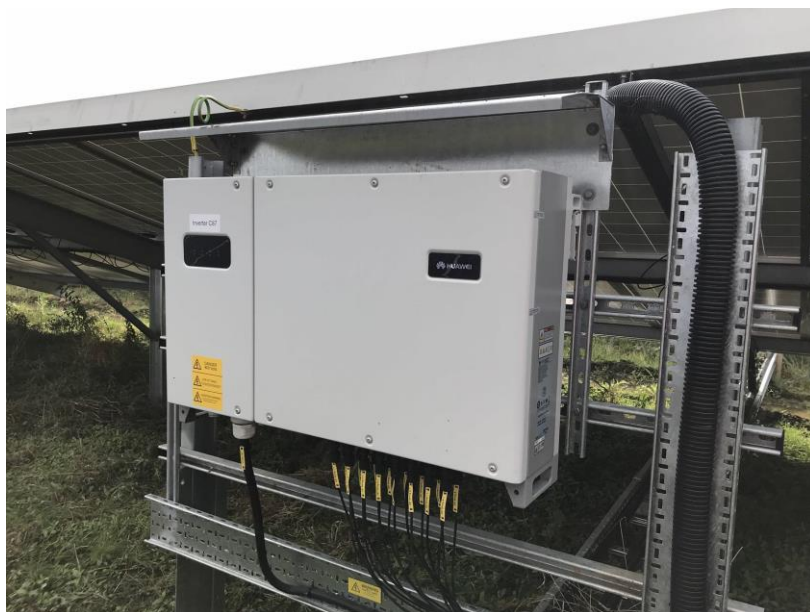
Slika 2: Detalj montaže izmjenjivača na podkonstrukciju
