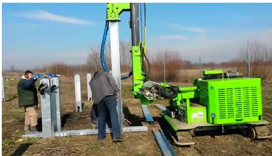
Slika 3: Prikaz stroja za zabijanje stupova u zemlju
