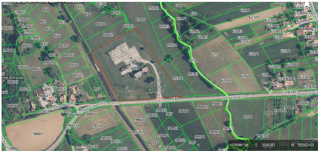
Slika 2. Lokacija TS 110/35 kV Daruvar (Izvor: Geoportal)
