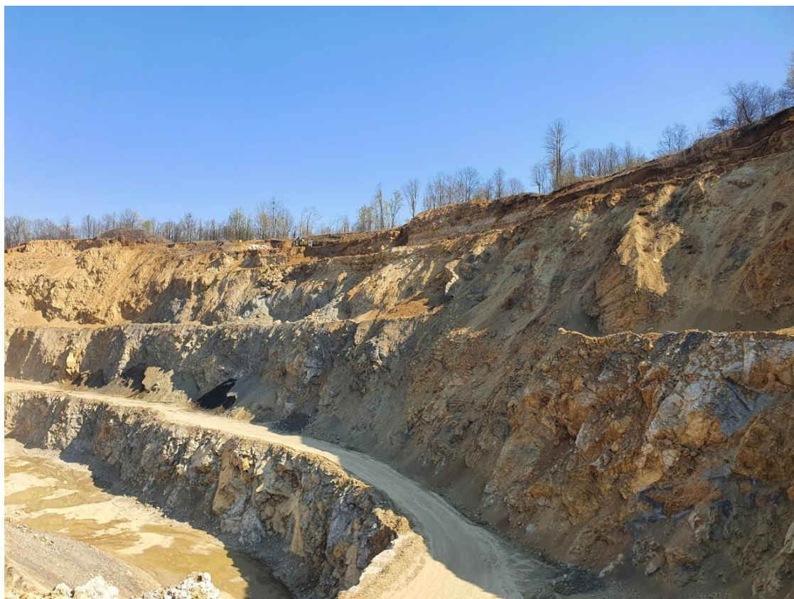
Slika 2./19. Postojeće stanje na eksploatacijskom polju "Međurače" [2]
