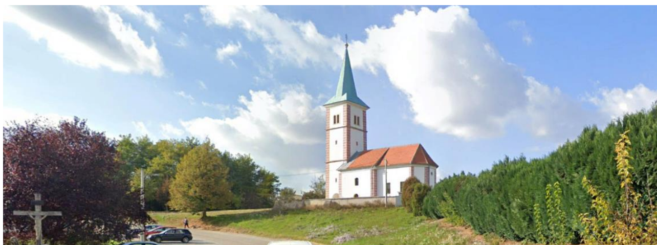
Slika 3.12. -1. Pogled na lokaciju zahvata (prometnica) u odnosu na crkvu Sv. Tome
