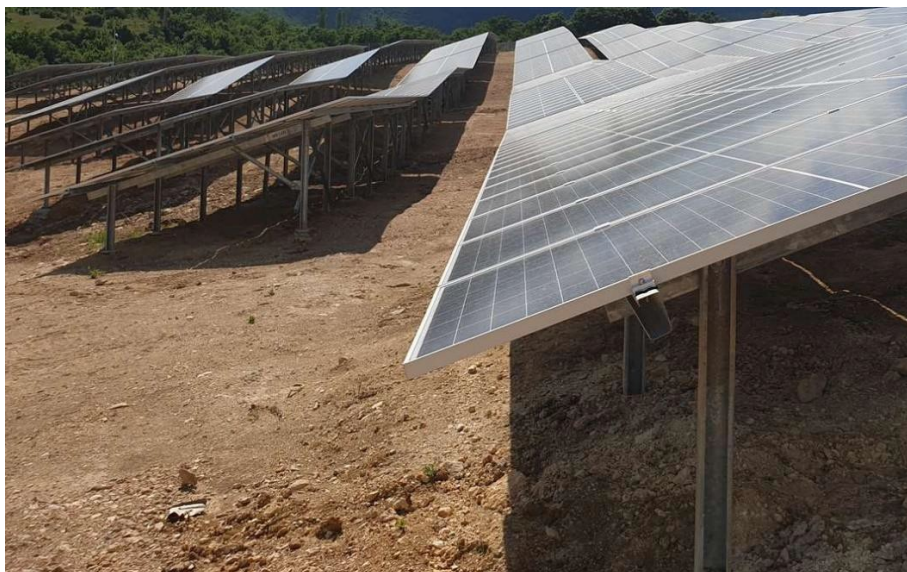
Slika 31. Primjer sustava fotonaponskih panela i stolova (Izvor: Idejno rješenje – Fotonaponski sustav – Sunčana elektrana Poljana Vojnička, Ured ovlaštenog inženjera elektrotehnike Ivana Medač, dipl.ing.el., siječanj 2024.)
