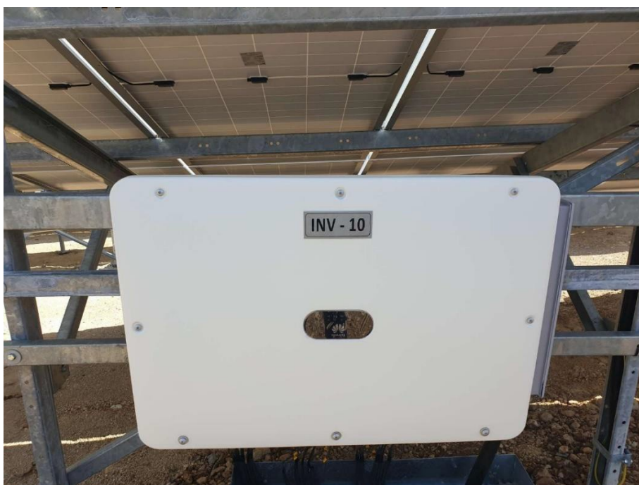
Slika 32. Primjer izmjenjivača DC/AC (Izvor: Idejno rješenje – Fotonaponski sustav – Sunčana elektrana Poljana Vojnička, Ured ovlaštenog inženjera elektrotehnike Ivana Medač, dipl.ing.el., siječanj 2024.)
