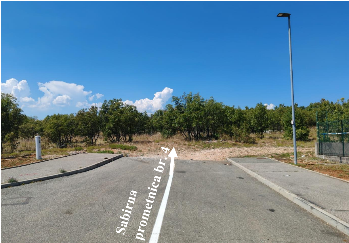
Slika 15. Pogled na zapad sa sabirne prometnice C1-E u Industrijskoj zoni (R-29) na lokaciju zahvata gdje će se u produžetku postojeće sabirne prometnice graditi sabirna prometnica br. 4
