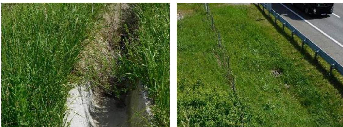
**Slika 3.7.5.4.** Rigoli i slivnik na odvodnom kanalu na stacionaži oko 14 + 000 (terenski obilazak, 6.5.2024.)
