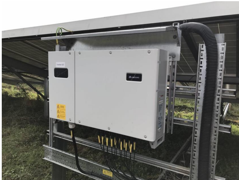
Slika 2: Detalj montaže izmjenjivača na podkonstrukciju
