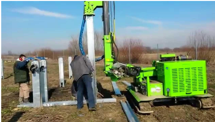
Slika 3: Prikaz stroja za zabijanje stupova u zemlju
