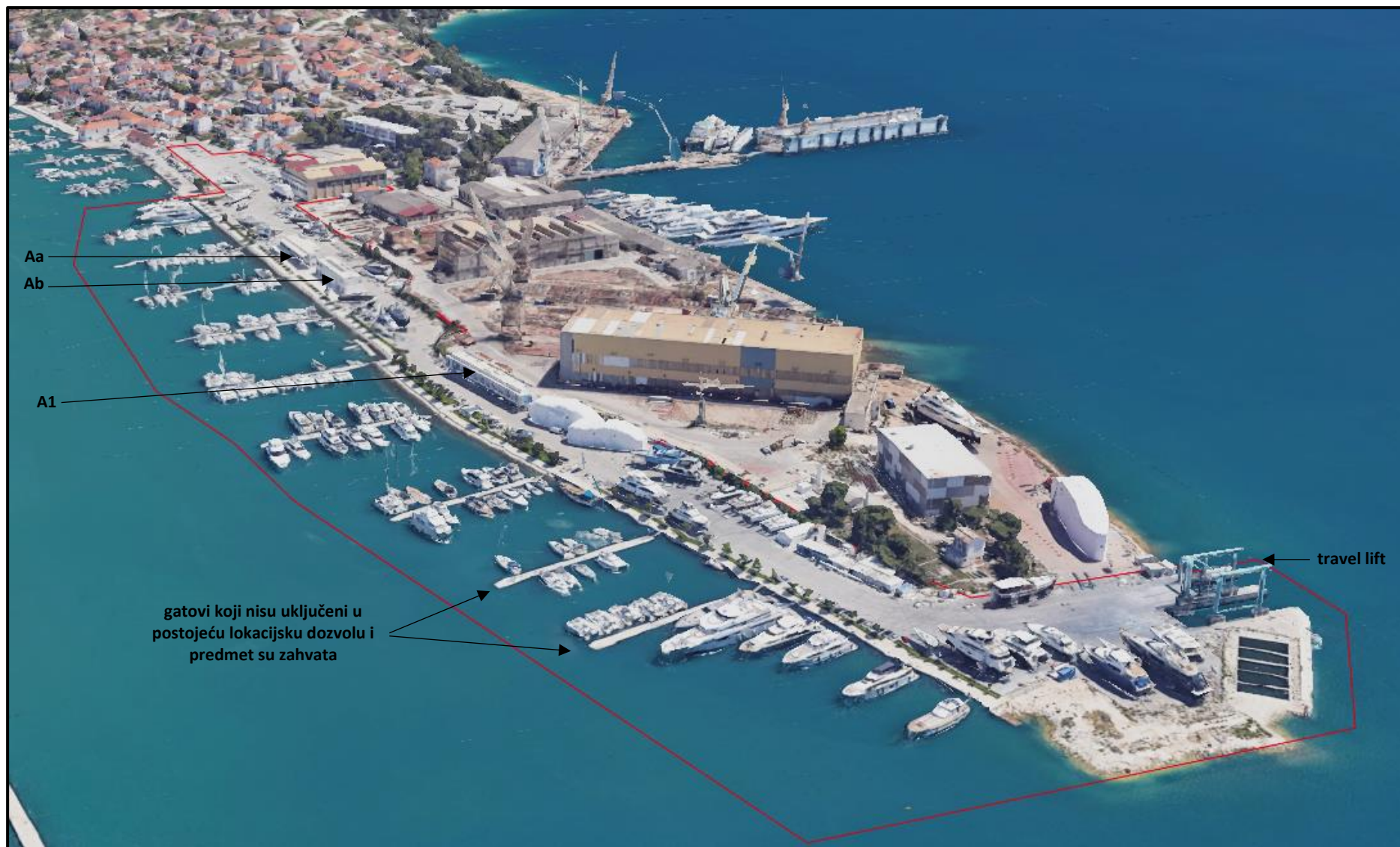
Slika 2.1-2. Pogled na prostornu cjelinu LNT SCT (etapa 1): postojeće stanje (izvor: Google Earth, 2023.)
