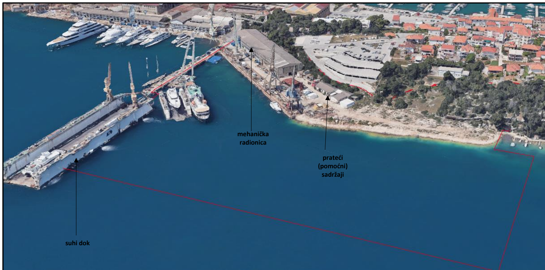
Slika 2.1-4. Pogled na prostornu cjelinu LNT Rt Ćubrijan (etapa 2): postojeće stanje (izvor: Google Earth, 2023.)
