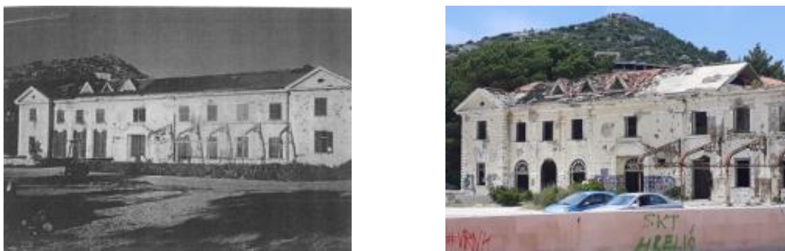
Slika 2.1-17. Pogled na dio zgrade hotela Grand izvorno stanje i stanje lipanj 2021.
