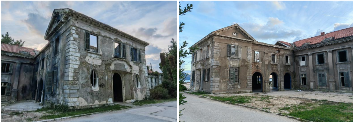
Slika 3.3.12-3. Hotel Grand – današnje stanje (lijevo - ulaz u hotel), (Izvor: Izvještaj o provedenim konzervatorsko-restauratorskim istraživanjima na Hotelu Grand i depadansi u Kupa, Restauo & Interior Pezzi, 2023.)
