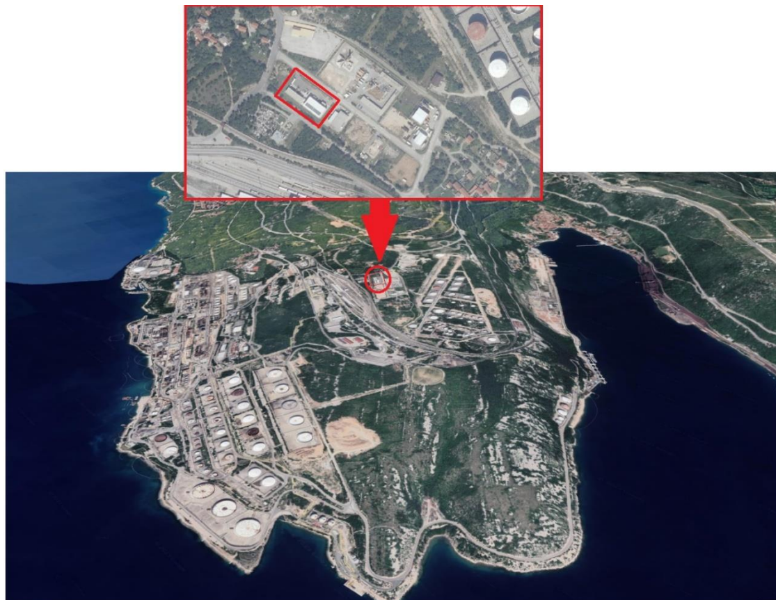
Slika 1. Okruženje perimetra posojećeg postrojenja Eko – centar Šoići
