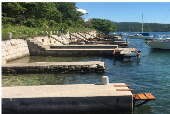
Pogled sa sredine izvedenog privezišta prema jugu
