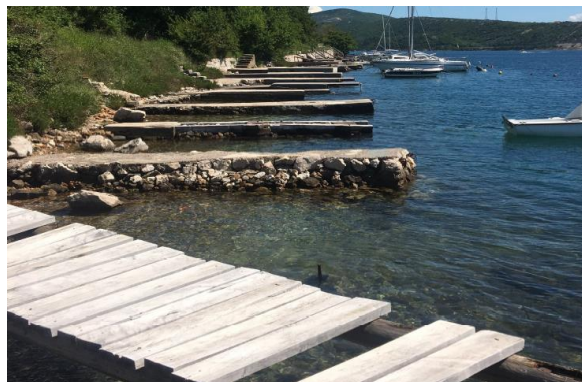
Pogled prema sredini izvedenog privezišta sa sjevera
