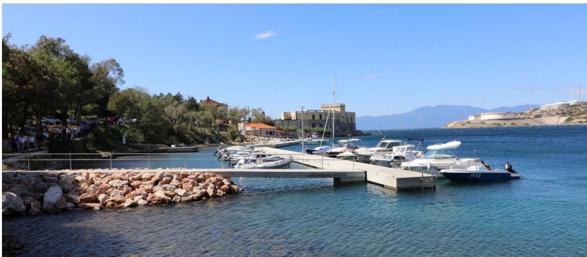
Slika 6. Luka Carovo (Grad Kraljevica), pasarele s pristupnim mostom
