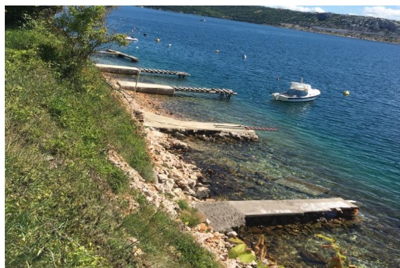
Južni dio izvedenog privezišta
