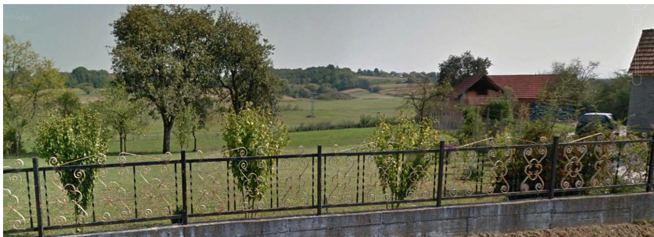
Slika 4.5 -1. Pogled na lokaciju UPOV Donja Voća
