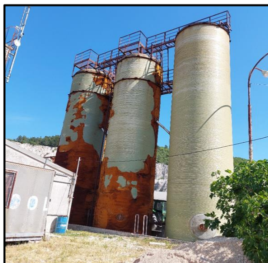
Slika 2.1-3. Postojeći digestori (preuzeto iz: Hidroprojekt-ing projektiranje d.o.o., 2022.)
