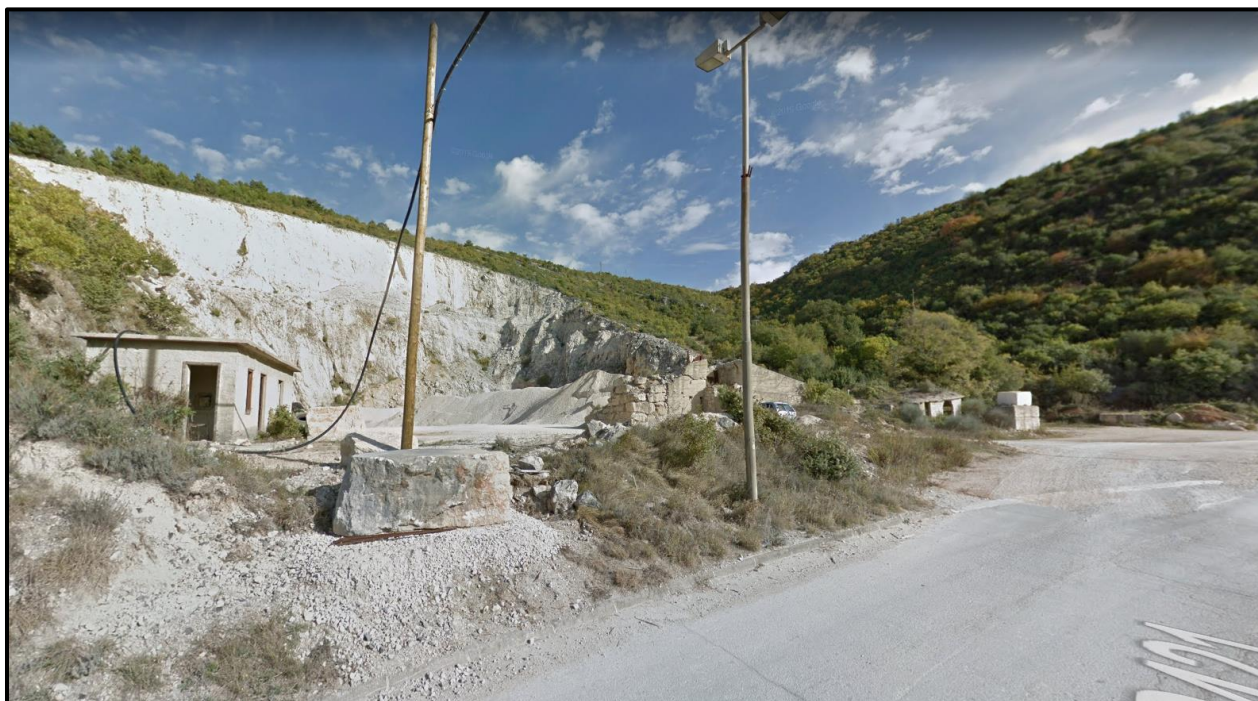
Slika 2.1-4. Pogled na napušteni kamenolom u kojem je planiran dio UPOV-a (izvor: Google Earth, 2022.)
