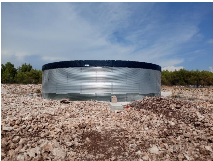
Slika 1.5 Montažna akumulacija - primjer
