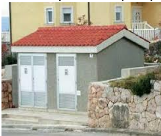
Slika 7: Prikaz tipskog montažnog betonskog kućišta tipa MTS 12(24)
