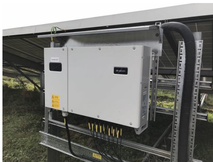
Slika 3: Detalj montaže izmjenjivača na podkonstrukciju
