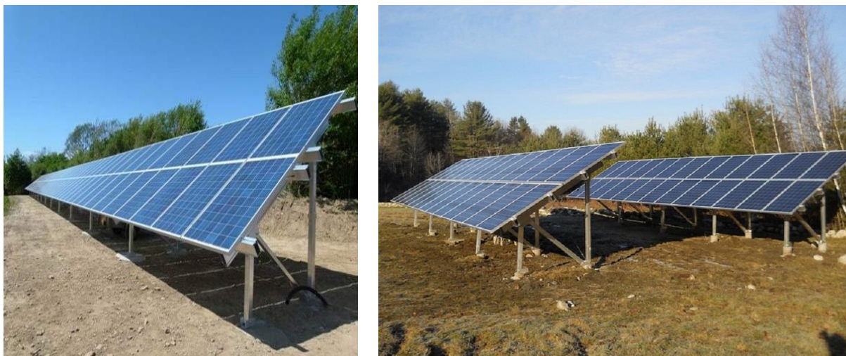
Slika 2: Detalj montaže podkonstrukcije sa temeljenjem (ilustracija)
