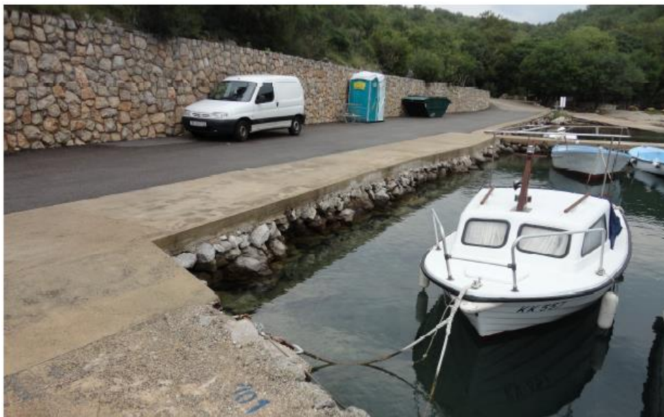
Slika 1.16 Pogled na obalni zid između gatova oznaka G4 i G5
