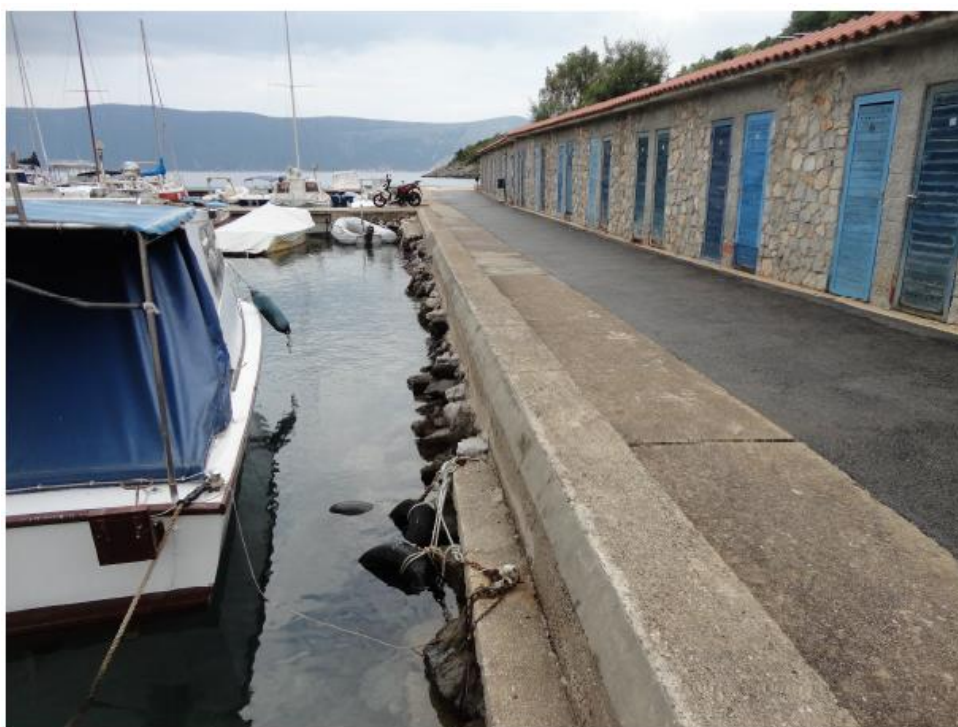
Slika 1.14 Pogled na obalni zid između gatova oznaka G2 i G3
