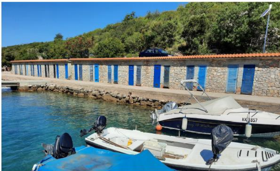
Slika 1.21 Pogled na objekte spremišta u sjevernom dijelu luke
