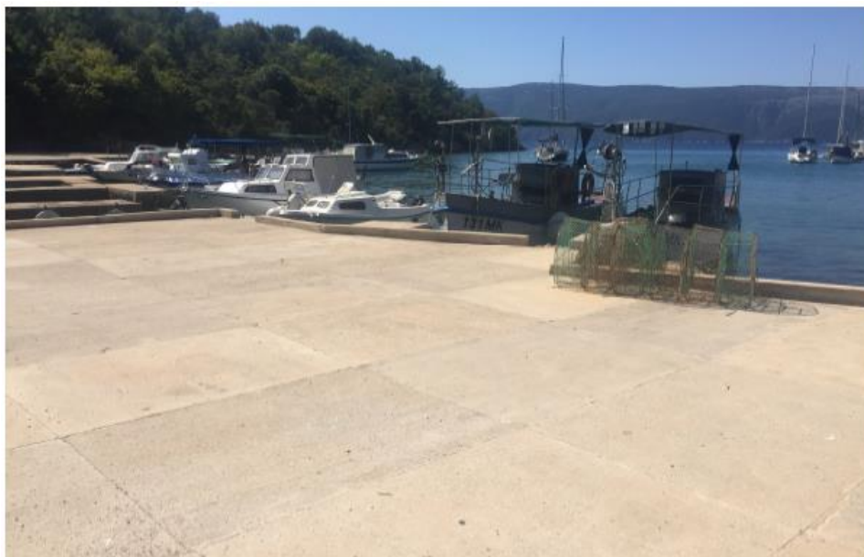
Slika 1.19 Pogled na betonski plato iza gata G6
