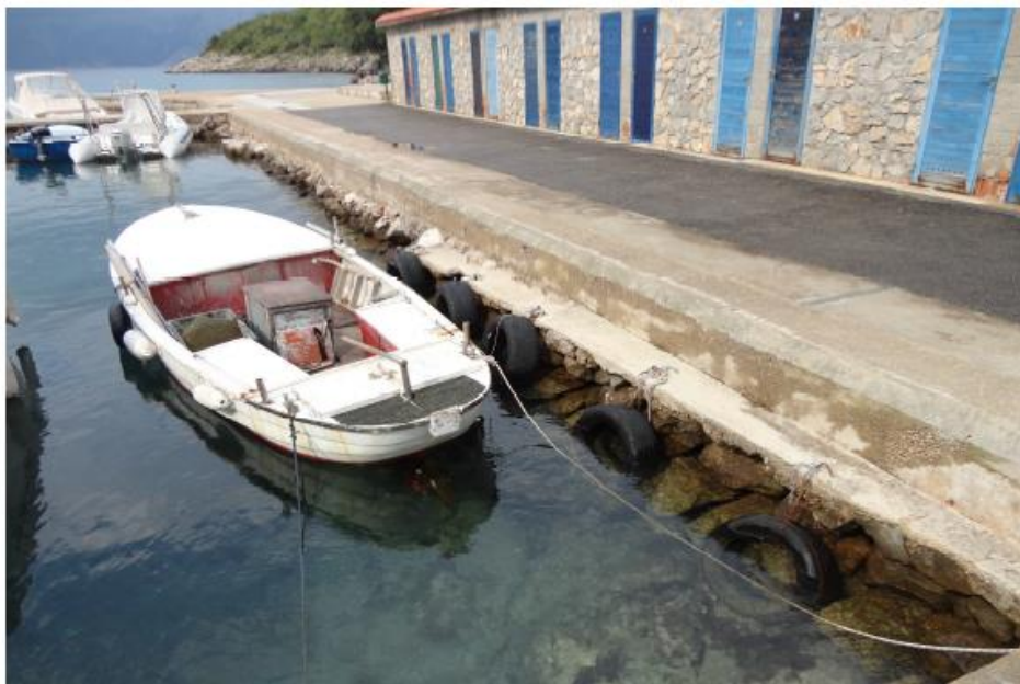
Slika 1.13 Pogled na obalni zid između gatova oznaka G1 i G2
