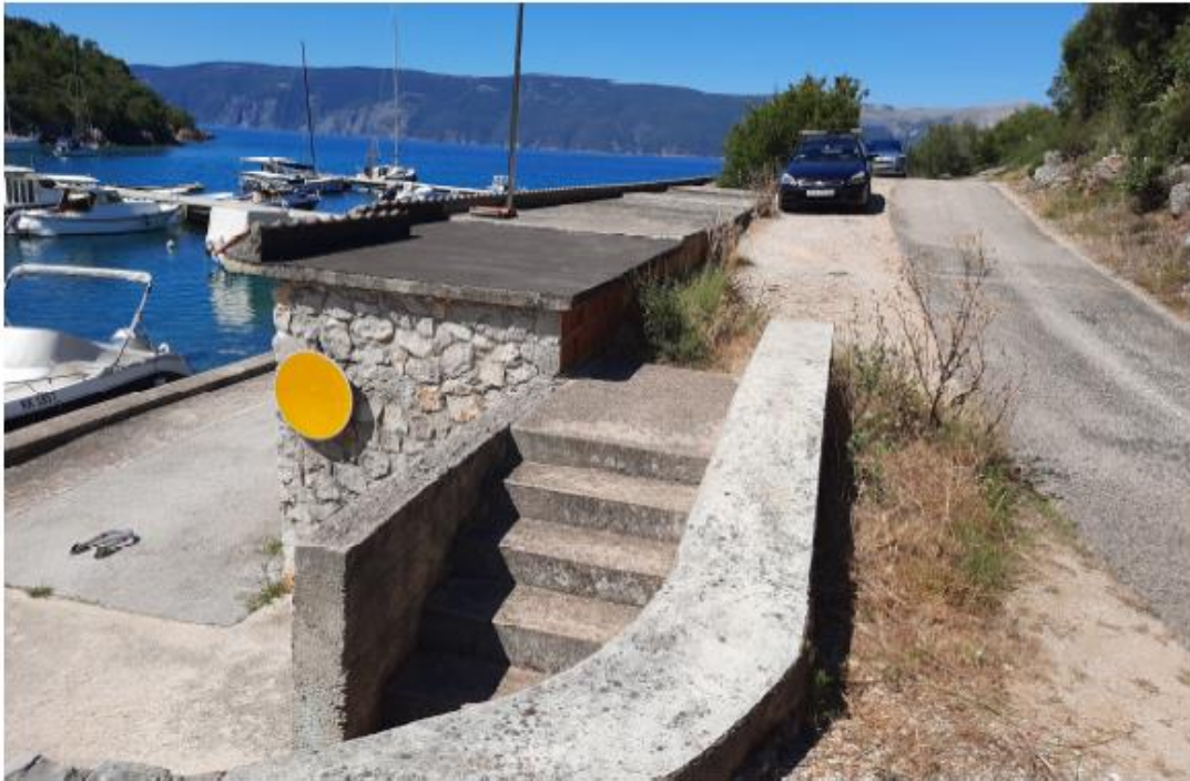
Slika 1.22 Pogled na krov spremišta
