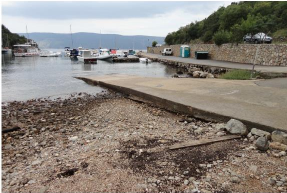
Slika 1.11 Pogled na istezalište u korijenu uvale
