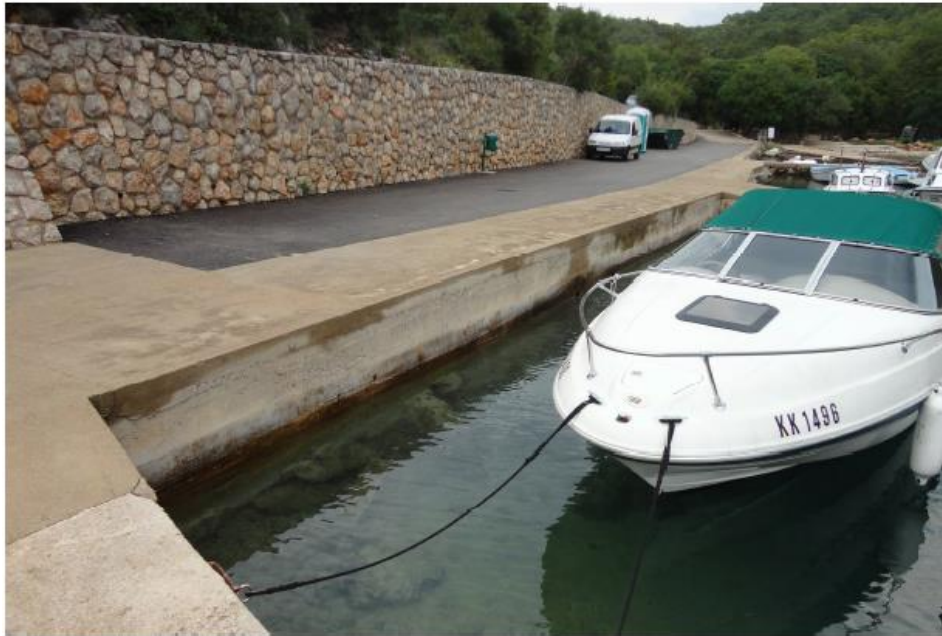
Slika 1.15 Pogled na obalni zid između gatova oznaka G3 i G4
