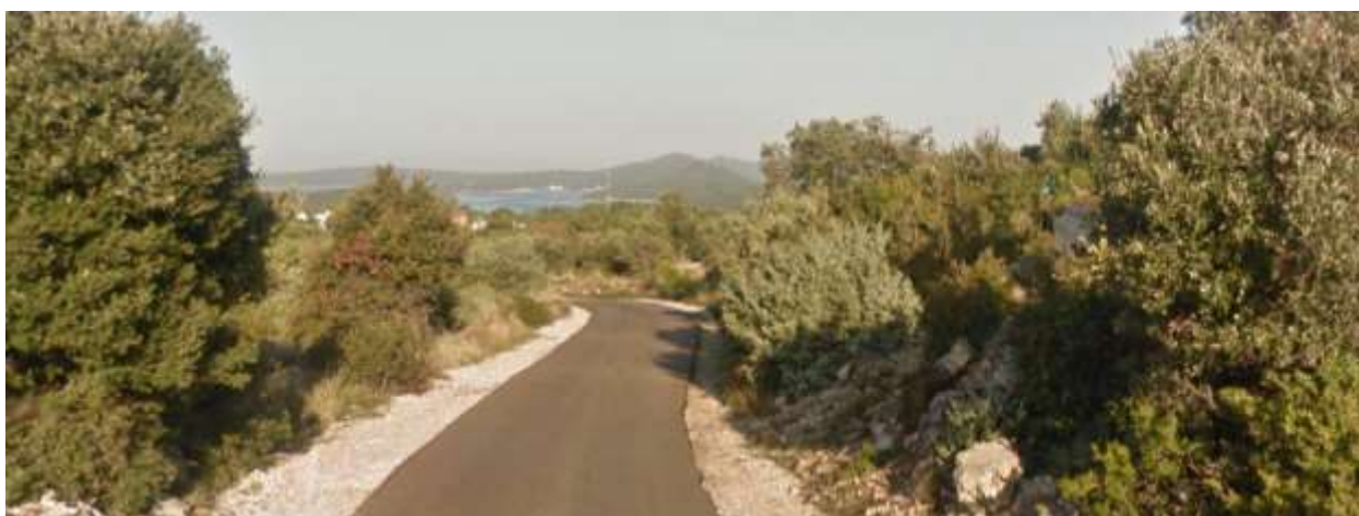
Slika 3.8/2 – Asfaltirana cesta sjeveroistočno od odlagališta
