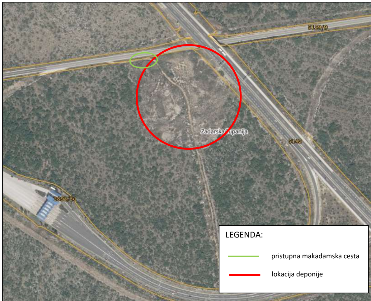
Slika 2.1.-2 Ortofoto prikaz lokacije deponije s vidljivom pristupnom makadamskom cestom sa sjeverne strane (Zemunik Gornji)
