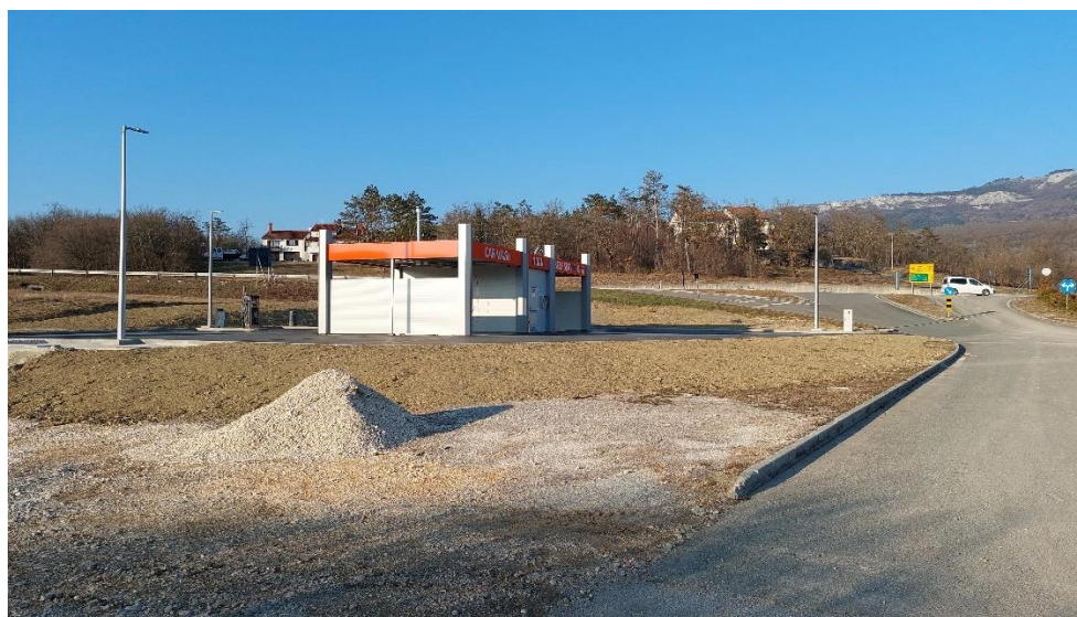
Slika 1.5 Praonica u gospodarskoj zoni – izgrađeni dio
