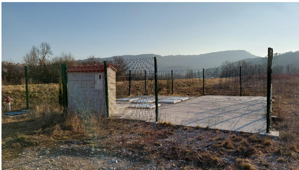
Slika 1.8 Lokacija crpne stanice CS-1
