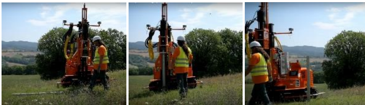
Slika 2.1-5 Priprema terena za postavljanje PV panela
