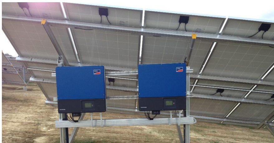
Slika 6. Način montaže pretvarača na potkonstrukciju; Izvor: Idejno rješenje: Solarna elektrana Sveti Ivan Žabno, ZOP 2128-CD; Broj projekta: 2128-CD-EE-21389, Izrađivač: IVICOM Consulting d.o.o., Zagreb, ožujak 2022.
