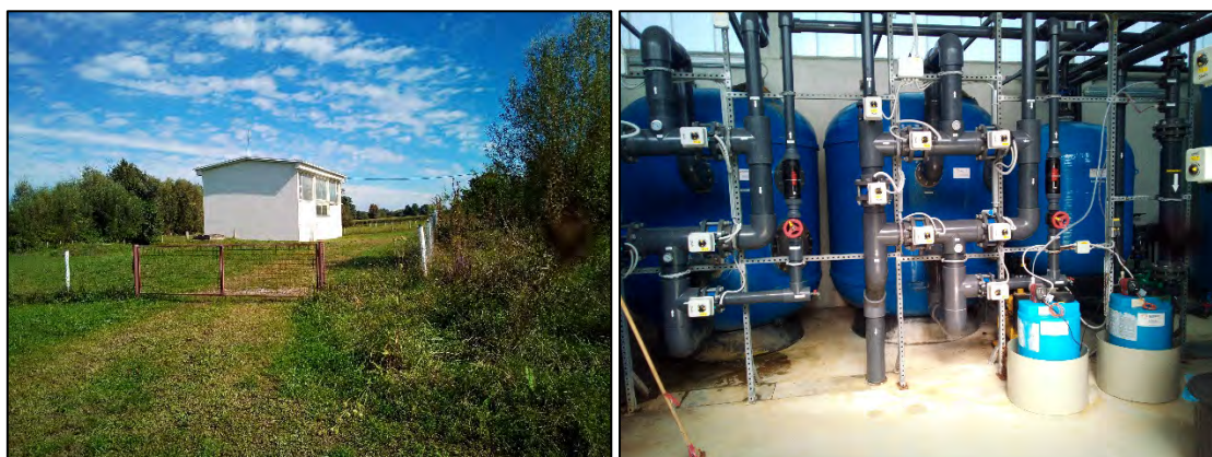
Slika 4. Zgrada i unutrašnjost vodocrpilišta
