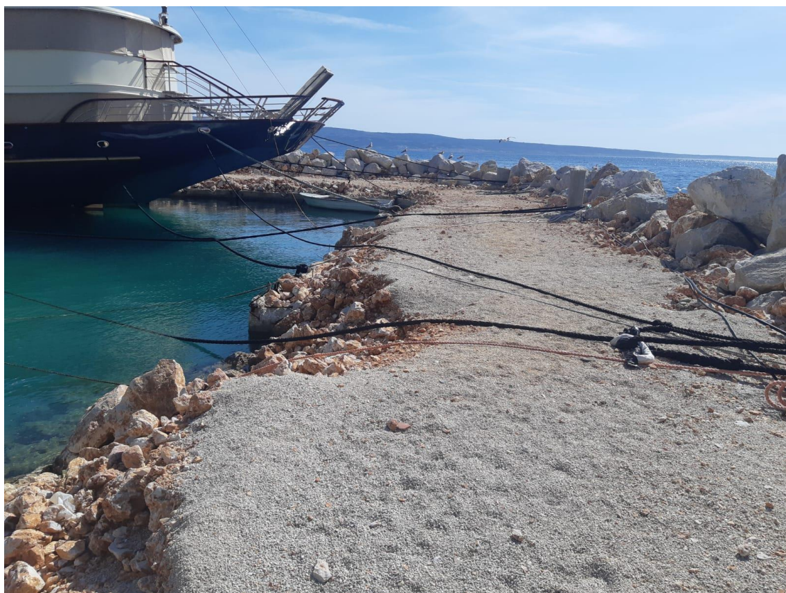
Slika 1.1-4 Postojeće stanje nasutog lukobrana (Zeleni servis d.o.o., svibanj 2021.)
