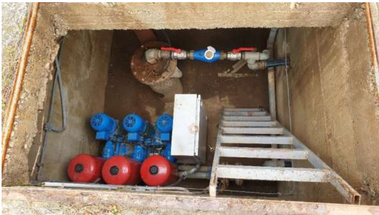
Slika 4. Hidroforsko postrojenje
