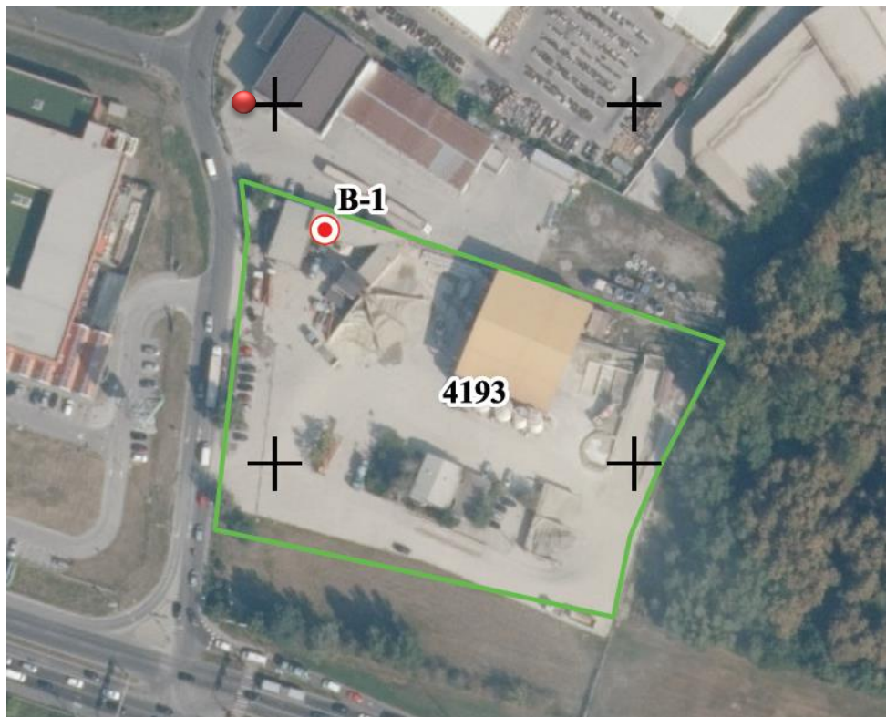
Slika 2. Prikaz lokacija zdenca B-1 na lokaciji betonare.
