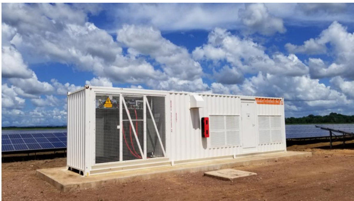
Slika 1./7. Primjer izmjenjivača, Gamesa Electric PV Station 5000; Izvor: www.gamesaelectric.com
