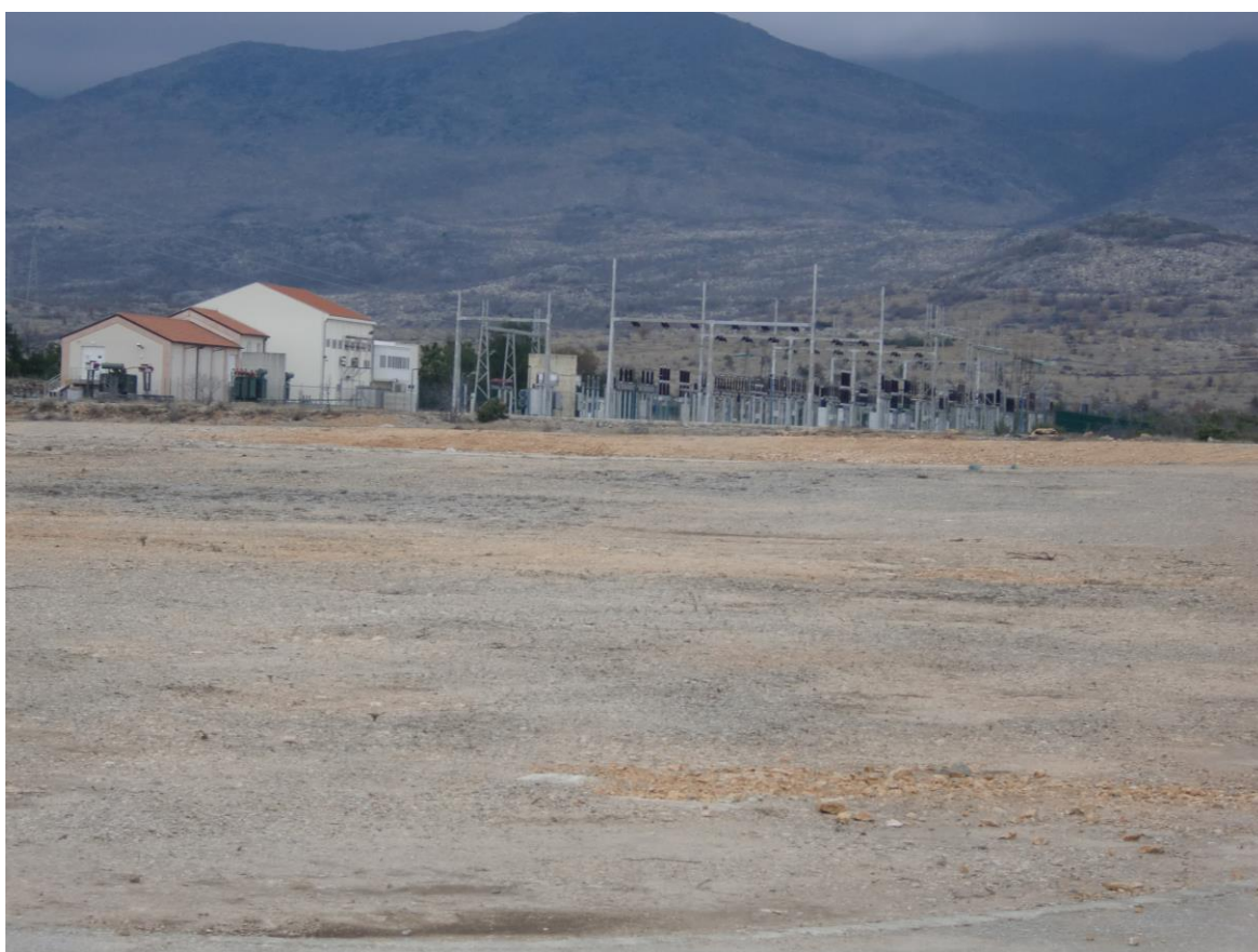
Slika 1./12. Postojeća TS Bravar 110/35 kV unutar zone Bravar
