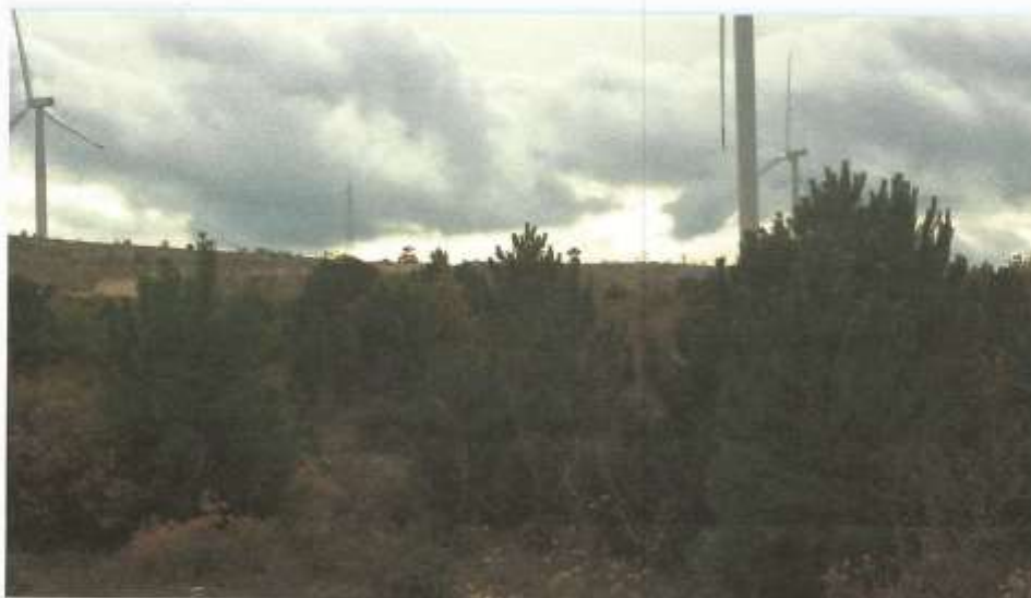
Slika 3 / pogled sa zapadnog ruba sjeverne strane na dio vjetrogeneratora istočne skupine
