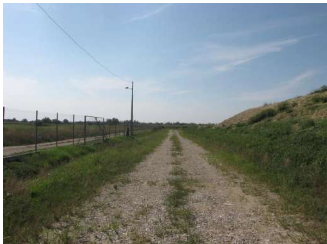
Protupožarni put (između ograde i tijela odlagališta)
