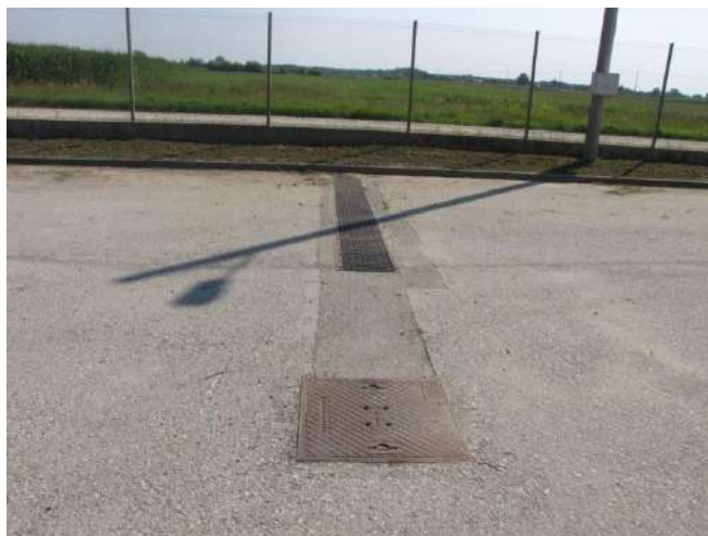
Prostor za pranje vozila sa separatorom ulja i masti
