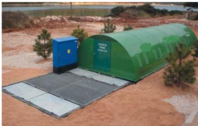
Slika 2.6. Primjer ugrađenog tipskog uređaja za pročišćavanje otpadnih voda
