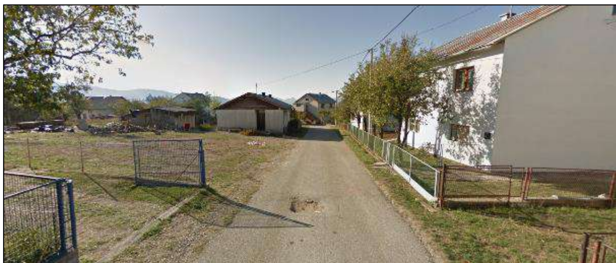
Slika 2.1.-4. Berislavićeva ulica u centralnom dijelu naselja Udbina u kojoj se nalazi jedan od izgrađenih neadekvatnih kolektora (oznaka b., slika 2.1.-.1); Izvor: Google Maps streeview
