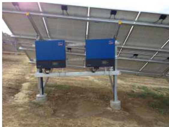
Slika 3: Način montaže invertera na podkonstrukciju
