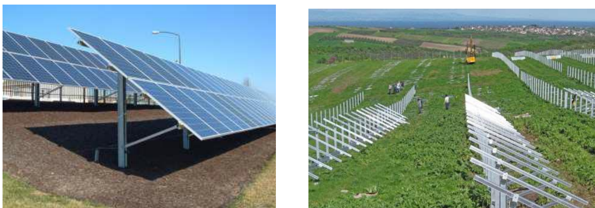
Slika 2: Detalj montaže na zemljanoj površini
