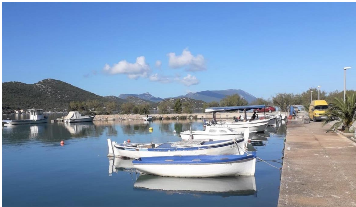
Slika 1.1-2 Betonska obala za privez plovila sa istočne strane pristana (Zeleni servis d.o.o., listopad 2020.)
