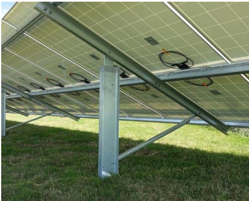
Slika 3. Primjer izvedbe nosive konstrukcije
