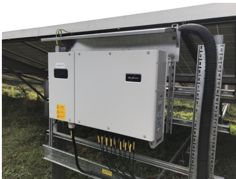
Slika 1.1.-5.: Primjer montaže izmjenjivača niza
