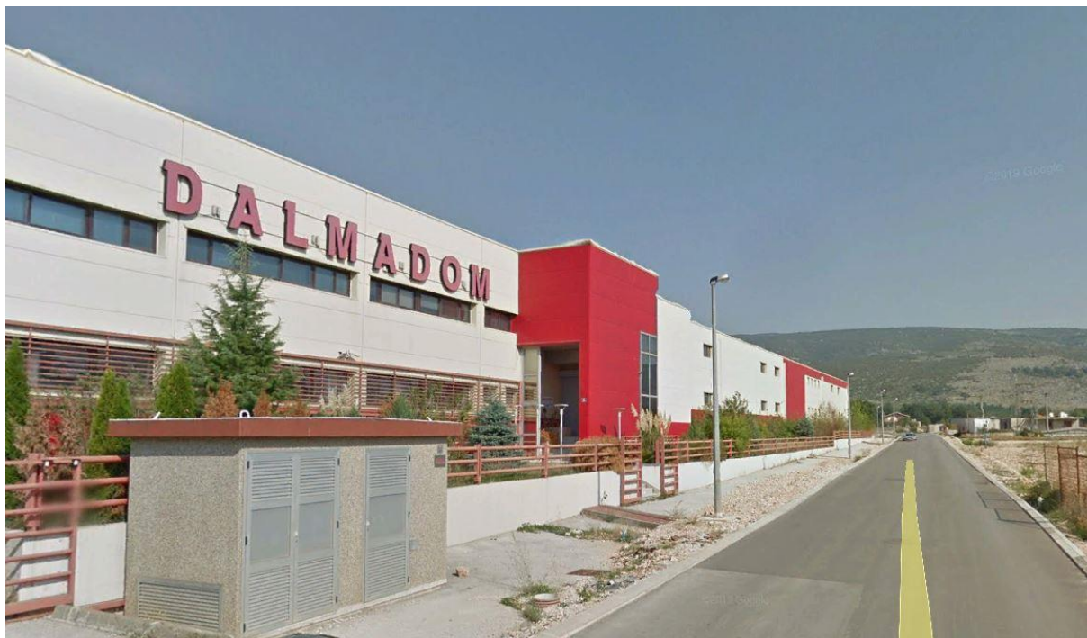
Slika 1.1-2 Građevina veleprodajnog skladišta i pristupna prometnica (Izvor: Google Earth)
