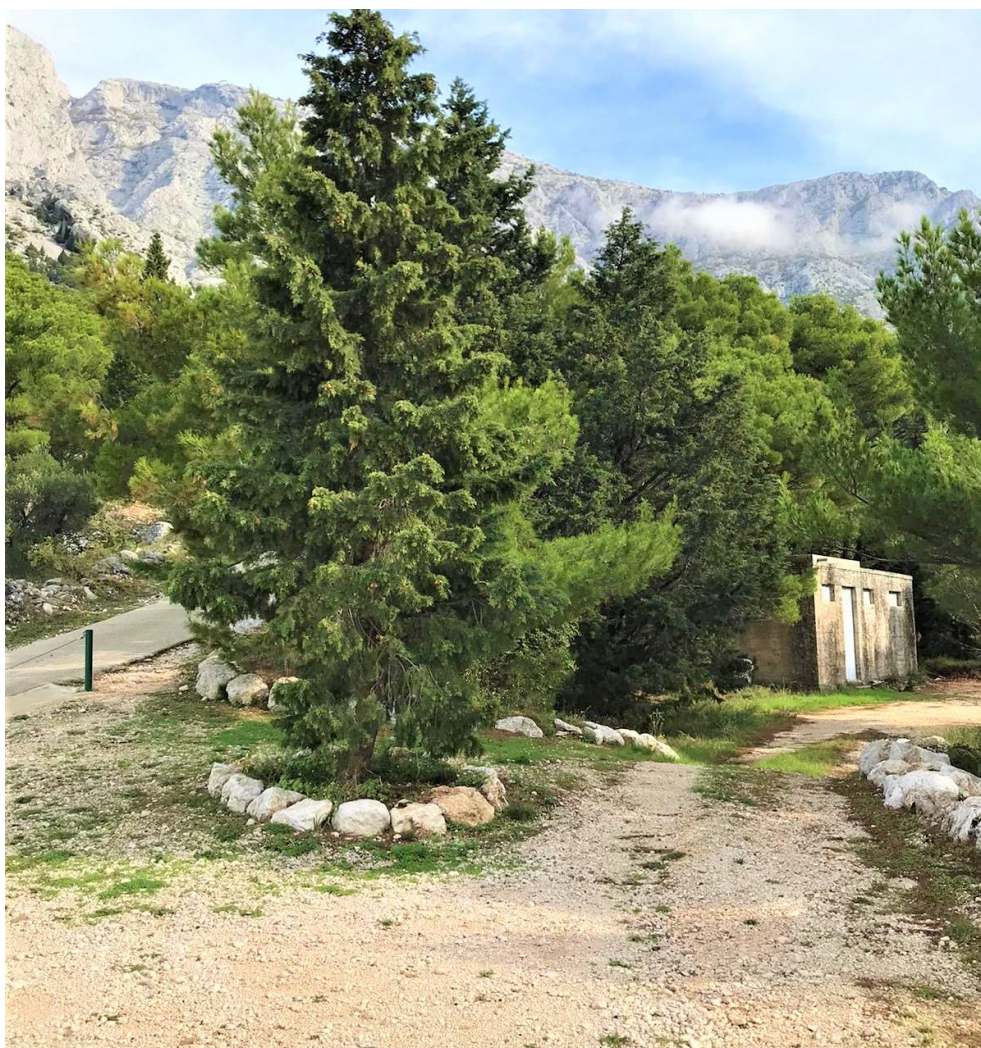
Slika 1.1-3 Postojeći komunalni objekt – skladište (Zeleni servis d.o.o. listopad, 2020.)
