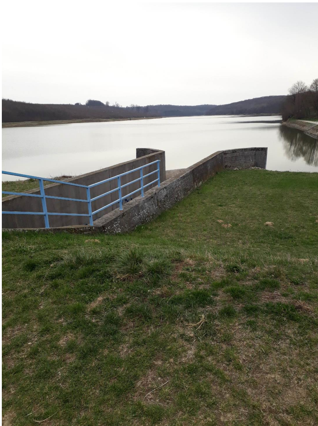
Slika 30. Pogled na akumulaciju LAPOVAC II s brane
