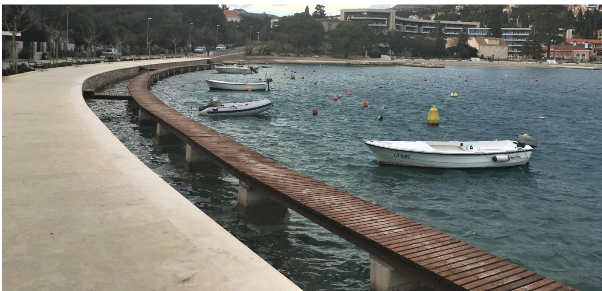
Slika 1.1-5 Postojeći obalni zid i pasarela (Zeleni servis d.o.o., prosinac 2019.)
